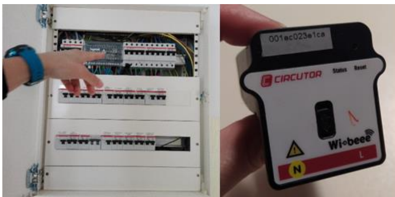
Figura 13: Elección del cuadro eléctrico a monitorizar mediante medidos de consumo eléctrico (Wi-beee), para determinar curva de demanda.
